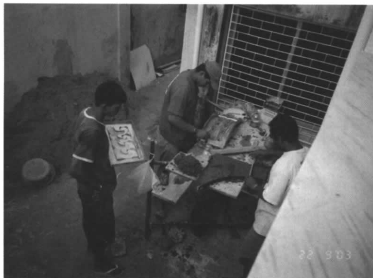
Figura h. Fabricação artesanal de ornatos no canteiro de obras. (2003)
