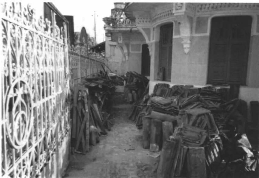
Figura f. Telhas avariadas selecionadas para limpeza ou rejeição. (2003)
