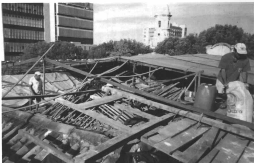
Figura c. Recuperação geral da coberta. (2003)
