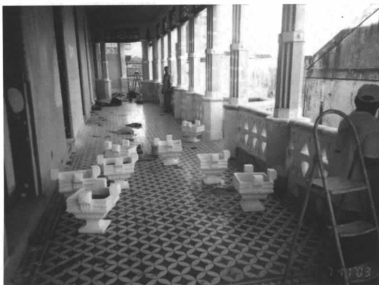
Figura j. Jarrões executados na obra, prontos para reposição. (2003)
