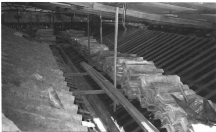
Figura e. Recuperação do madeiramento da cobertura. Limpeza e substituição de telhas. Observar a longa calha interna. (2003)
