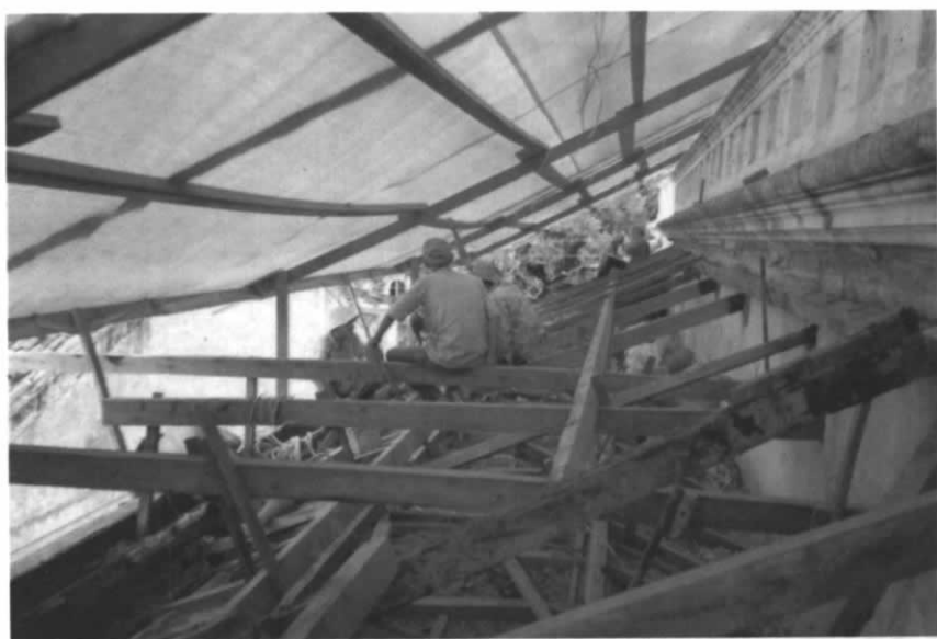
Figura d. Recuperação da coberta da varanda de acesso. (2003)
