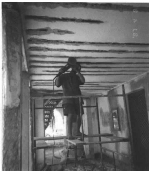
Figura m. Limpeza da oxidação das vigas metálicas das abobadilhas.
